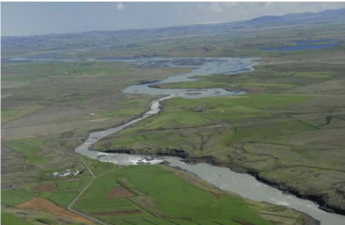
Mynd 4. Horft að Urriðafossi og upp farveg Þjórsár á fyrirhuguðu virkjunarsvæði. Heimild: Orkustofnun (2015).
