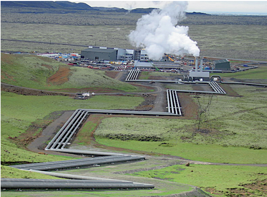
1. mynd. Hellisheiðarvirkjun. – Hellisheiði geothermal power plant. Ljósmynd. /Photo: Rögnvaldur Ólafsson.
