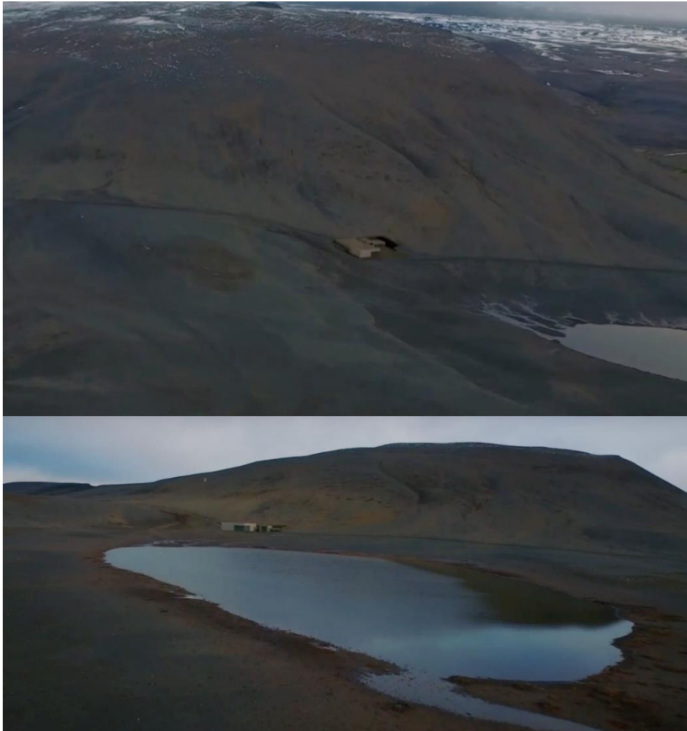
Mynd 7. Skjástot úr kynningarmyndbandi Landsvirkjunar um Skrokkölduvirkjun. Myndirnar sýna afstöðu sýnilegra mannvirkja við Sprengisandsleið (vegurinn er dökk lína við fjallsrætur). Í baksýn eru Hnausalda og Skrokkalda. (Landsvirkjun, 2016).
